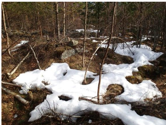
Tontti nro 27:n koillislaidalla havaittu kivijalka. Itään.
